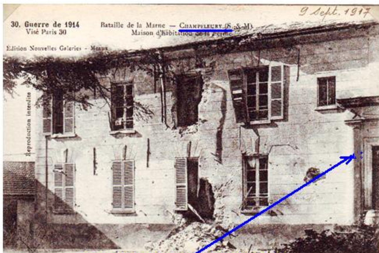
Façade de l'entrée principale
